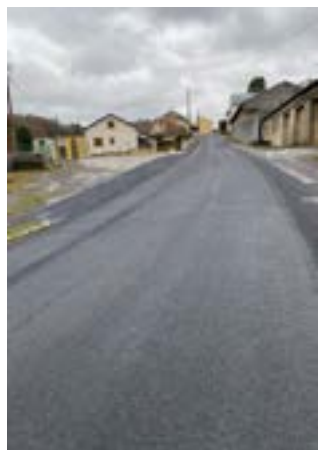
Goudronnage de l'Avenue du Montalet
