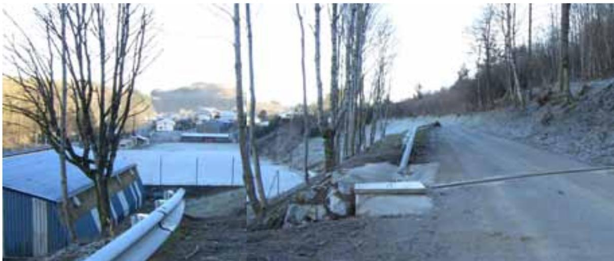
Prolongement de la glissière de sécurité au-dessus du stade de foot et création d'un réseau pluvial rue Flandres Dunkerque en direction du carrefour des 3 ponts.
