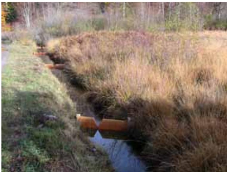
Création de seuils de retenue sur zone humide de Martinou afin de stabiliser à nouveau le niveau de l'eau pour limiter l'assèchement de la zone humide.
